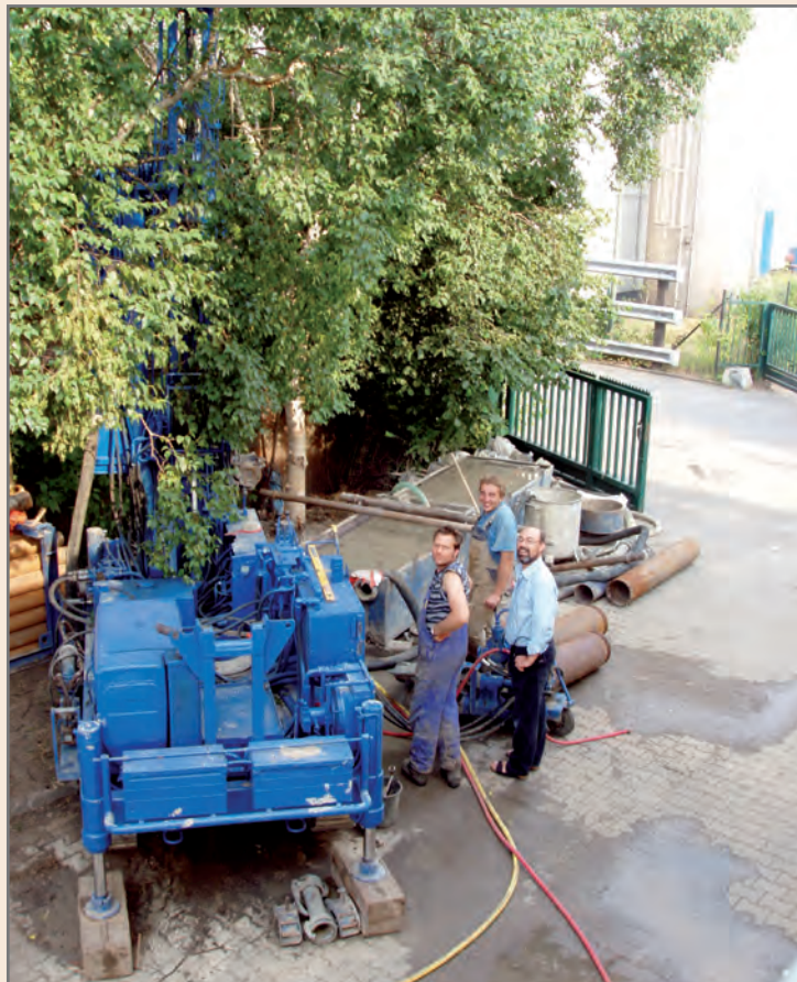
Während der Brunnenbohrung im Sommer 2005 – dabei sein ist Chefsache.
